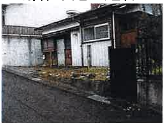
解体予定の建物
